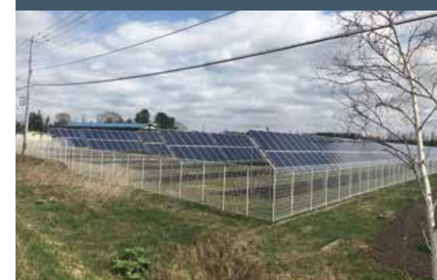
太陽光発電所へのフェンス設置
